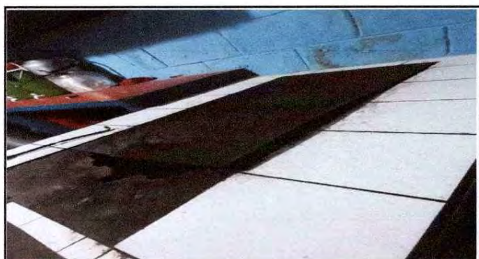
Foto 3: Cocina (Sustitución de plancha de metal de tres hornillas)
