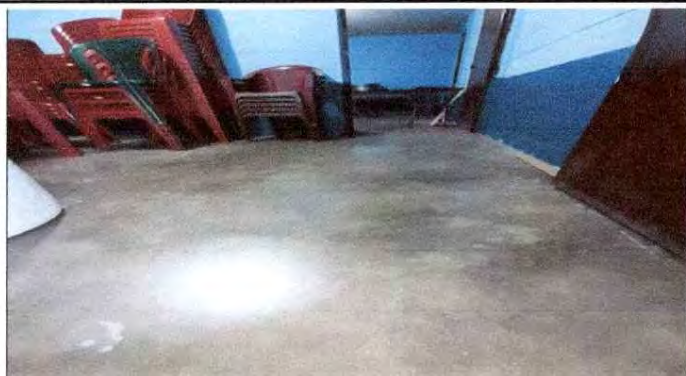
Foto 1: Cocina (Sustitución de piso de torta de concreto por piso ceramico)
