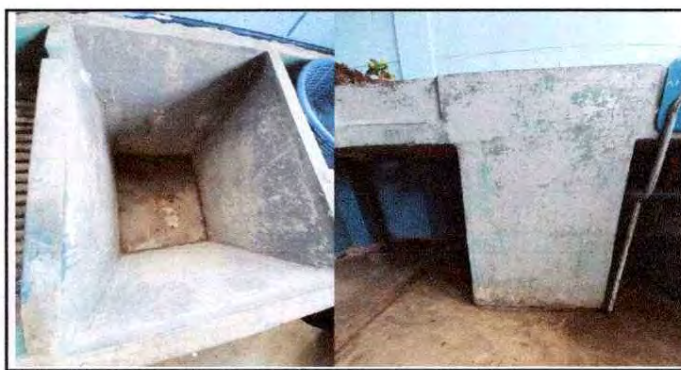
Foto 6: Cocina (Sustitución de pila de dos lavaderos)
