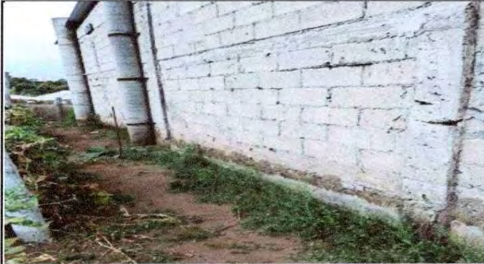
Foto 7: Cernido, alisado y sellado de grietas en el muro, de paredes.
