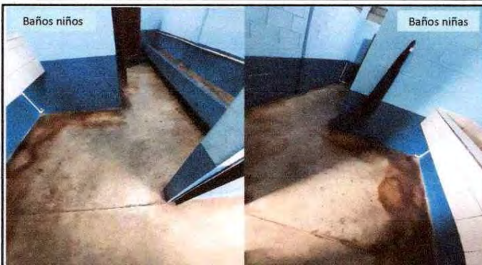
Foto 14: Piso (Sustrución de piso de torta de concreto por ceramica)
