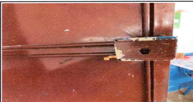
Foto 11: Herrería (Sustitución de chapa)
