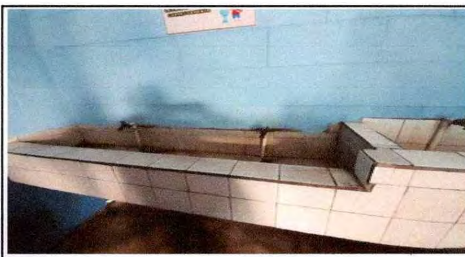
Foto 16: Sustrucion de lavamanos de concreto por lavamanos de losa
