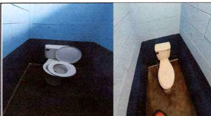
Foto 15: Servicios Sanitarios (Sustrución inodoros)
