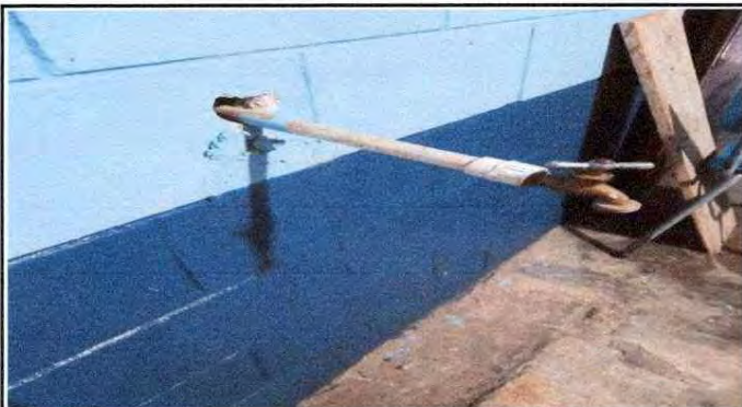
Foto 9: Red de agua potable cocina (Sustitución de llave de chorro)
