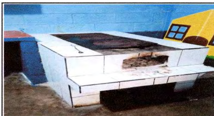
Foto 4: Cocina (Instalación de azulejo en estufa rural)
