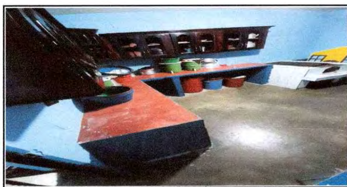
Foto 5: Cocina (Repación azulejo muebles de cocina)
