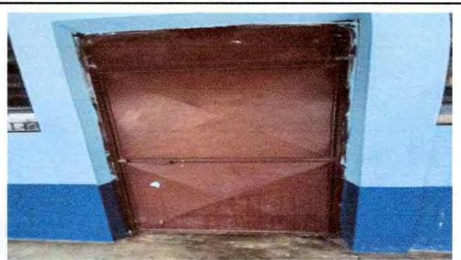
Foto 10: Puertas de metal (mantenimiento a estructuras, aplicación de pintura)
