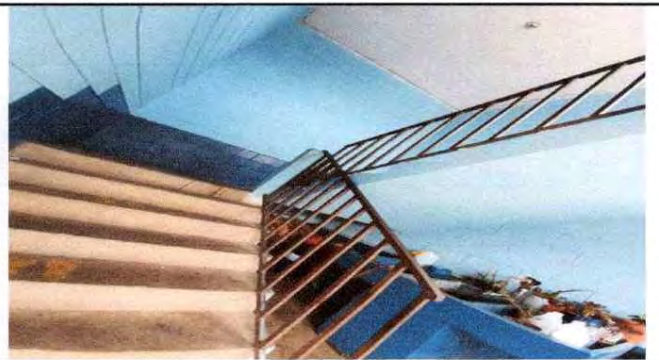
Foto 12: Mantenimiento de barandas de metal.
