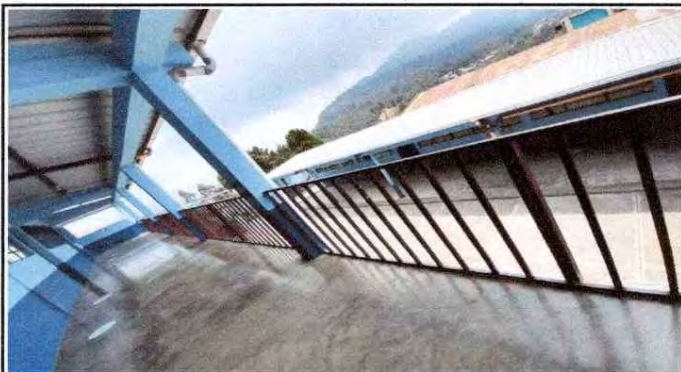
Foto13: Sustrución baranda de metal.
